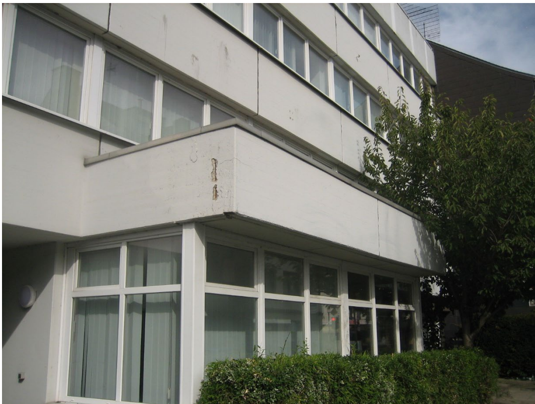
Mühlenstraße 61-63, Straßenseite (Südseite)
