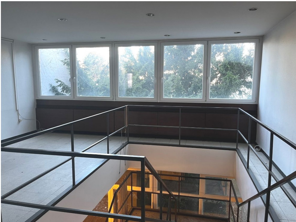
...und Austritt im ersten Obergeschoss
