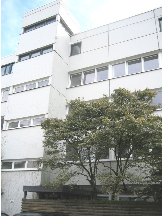
Mühlenstraße 61-63 Hof (Nordseite)
